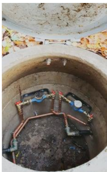
Figur 7 Exempel på godkänd montering av vattenmätare i mätarbrunn.
